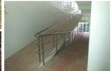
Rampe d'accès pour fauteuils roulants
