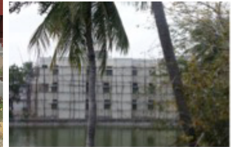
Février 2015, enduit de la façade
